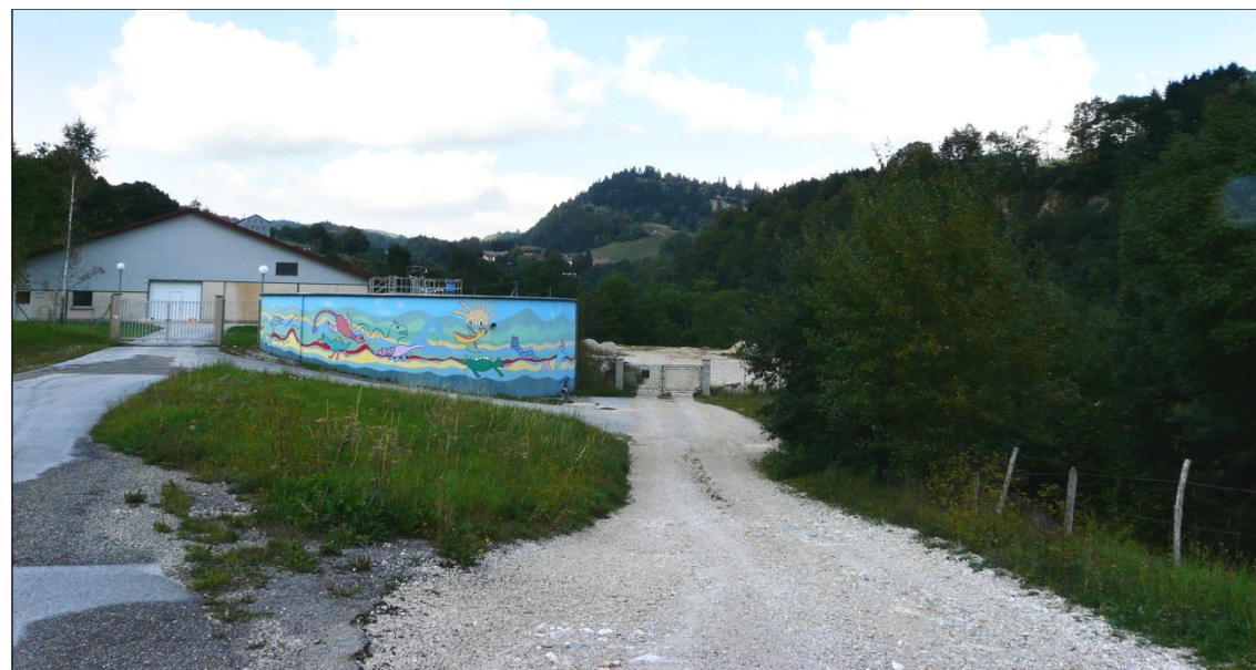
La station d'épuration depuis le chemin d'accès
