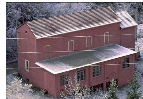
Centrale de la Mutuelle électrique du Haut-Jura
