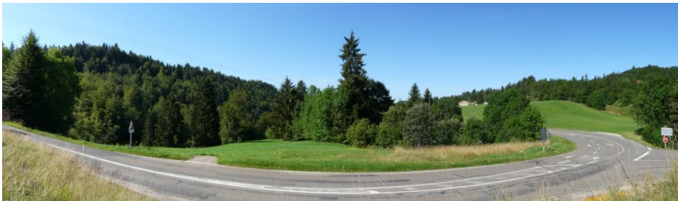
Photo 1 : Vue en surplomb de la RD25
